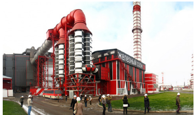
Первоуральский новотрубный завод
